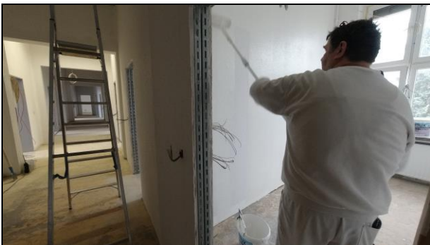
Intensive Instandsetzung vor dem Einzug! ( Foto: RMS)
